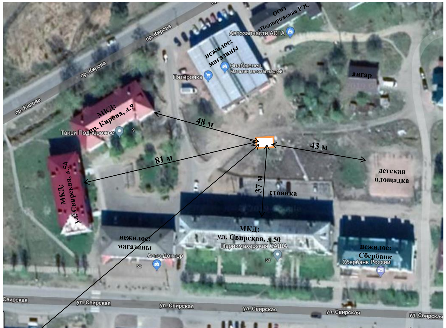
Место размещения площадки ТКО.
