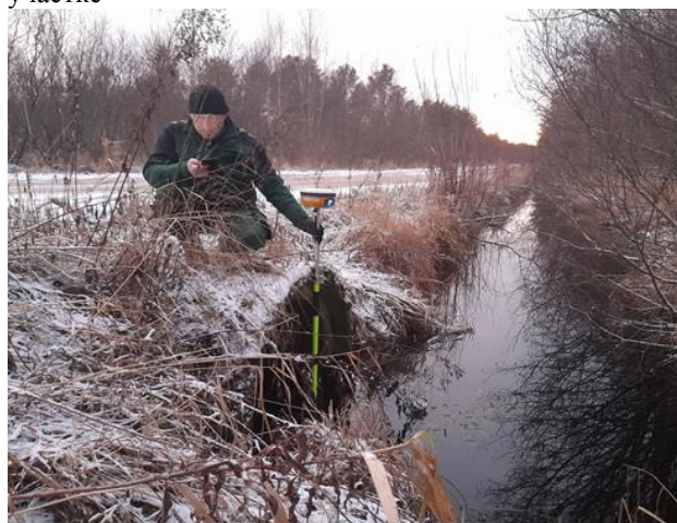
Рисунок – Водопропускная труба в теле дорожной насыпи автодороги в д.Замошье
