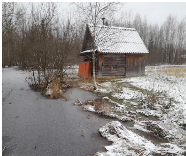
Рисунок – Юго-западная граница СНТ Metallurg 2. Подтопление нежилого строения на дачном участке
