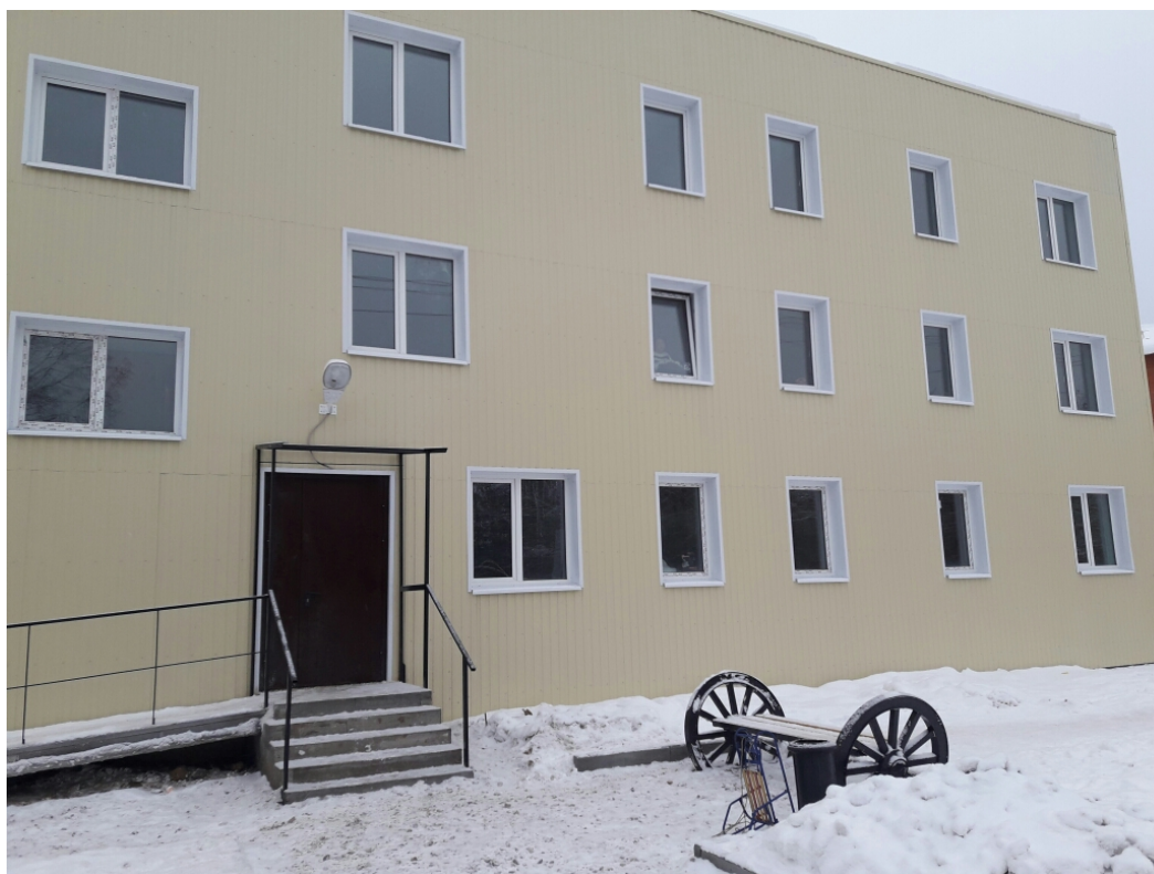
Жилой дом в поселке Никольский на ул. Лисицыной, д.29-а
