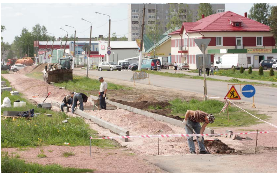
Ремонт тротуара, фото В. Бартенева
